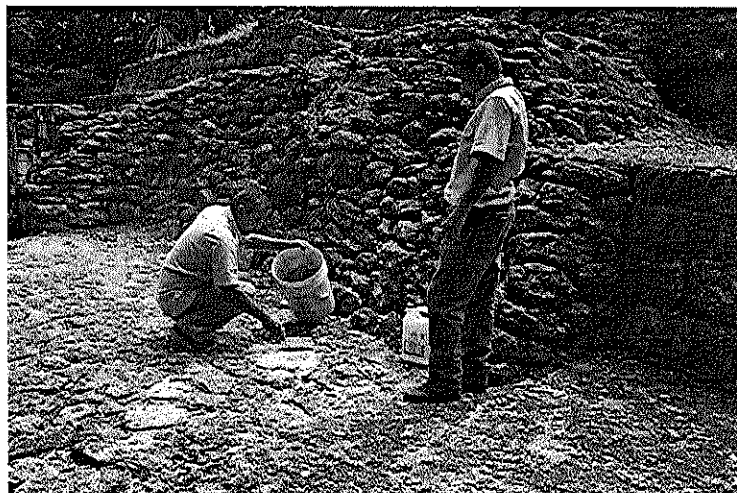
Foto 9. Aplicación de mezcla durante reintegro de piedras, Edificio 4, Grupo Maler, Yaxha
